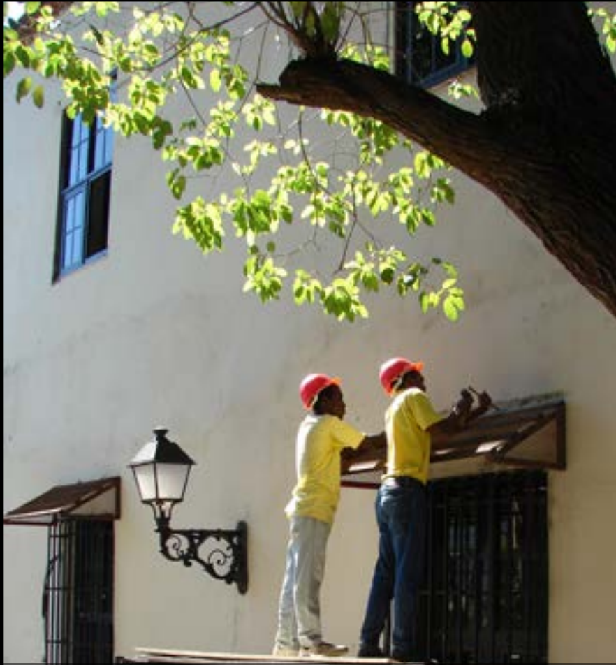
Intervención: Revestimiento en estructura de toldos en huecos de ventanas.
