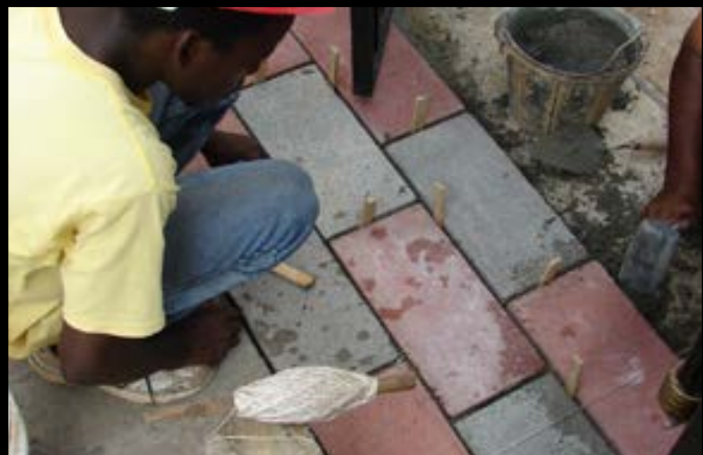
Intervención: Colocación de adoquines en la entrada principal.
